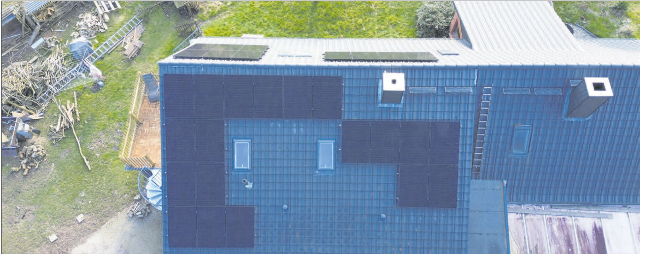
PJ-Industries bietet seinen Kunden ein Komplettpaket rund um Photovoltaik-Anlagen.
