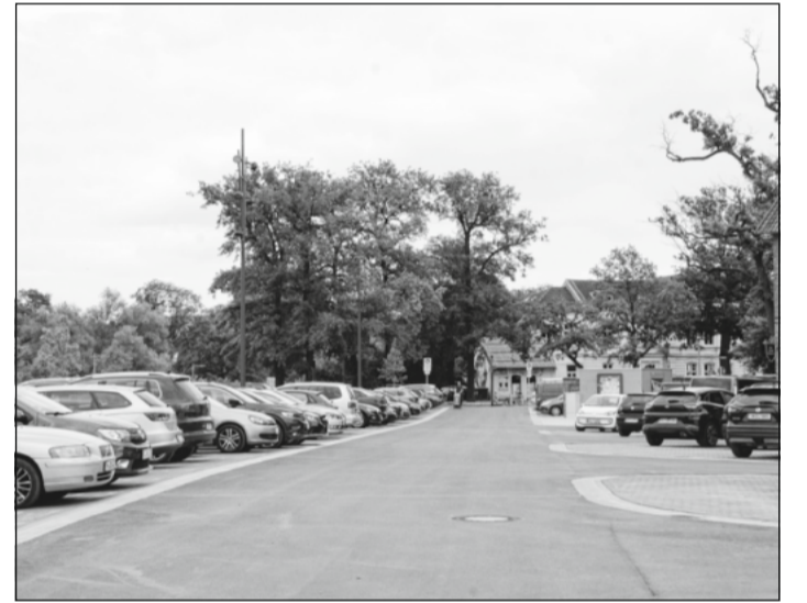
Der Ausbau des Parkplatzes auf der Allerinsel geht gut voran.
