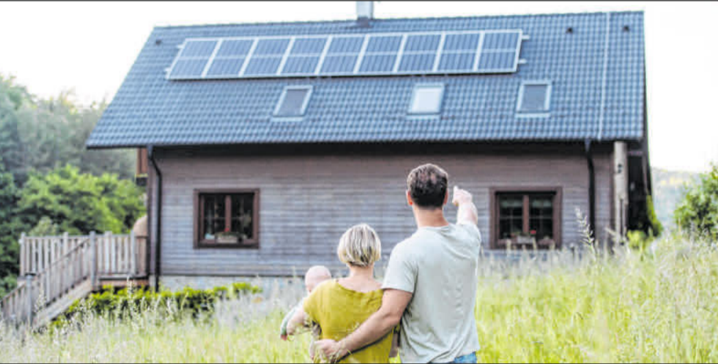
Ein privates Ökokraftwerk auf dem Dach: Photovoltaikanlagen können einen wichtigen Beitrag zur Energieversorgung der Zukunft leisten. Foto: DJDIE.ON/Getty Images/Halfpoint
